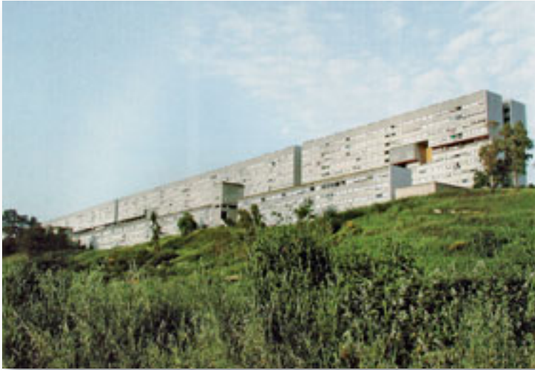
Abb. 4: Rom Corviale – 1 km Variante der Unite d'habitation, 1980 Foto: M. Stojan
