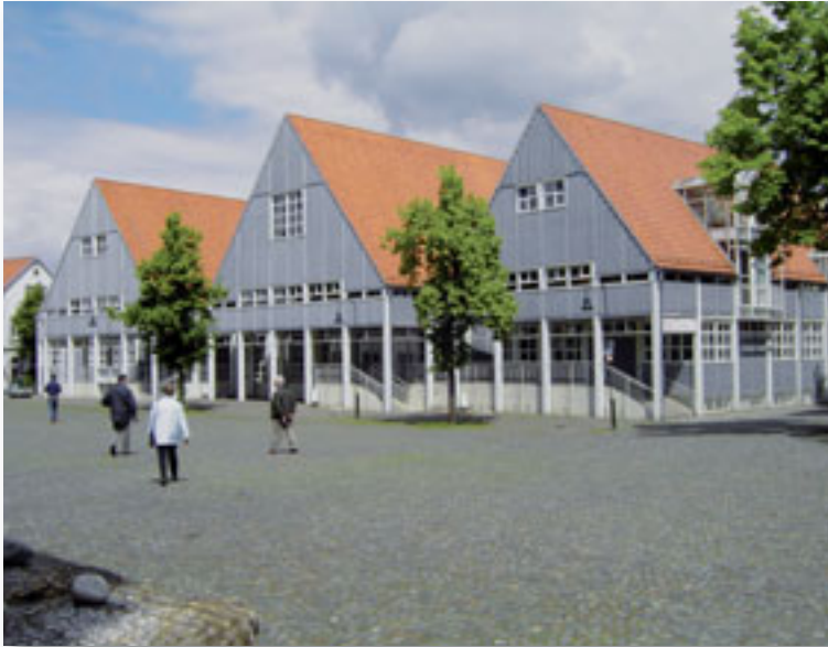
Abb. 7: Rheda-Wiedenbrück – Stadthaus, Arch. Schürmann Köln, 1988
