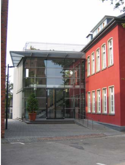
Bsp.6: Ein weniger spektakuläres, jedoch ebenso vorbildliches Beispiel: Der neue Anbau mit Foyer und innerer Erschließung (Treppenanlage) ist mit moderner Materialität vor das Bestandsgebäude gesetzt worden. Die Transparenz des Anbaus und die unter die Traufe gesetzte Form lassen ursprüngliches und angefügtes Gebäude ablesbar. (Zülpich)
