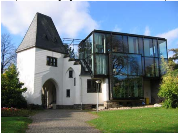
Bsp.9: Historisches, modern ergänzt: Das Torbauwerk wurde ergänzt durch einen modernen, farblich jedoch zurückhaltend gestalteten Kubus, der auf die Mauer aufgesetzt wurde. Der starke Kontrast zwischen beiden Bauwerken ist dann vertretbar – und kann besonderen Reiz entfalten, wenn die Ablesbarkeit der Epochen gegeben ist, und die historische Substanz nicht negiert (oder gar beseitigt) wird. (Koblenz)
