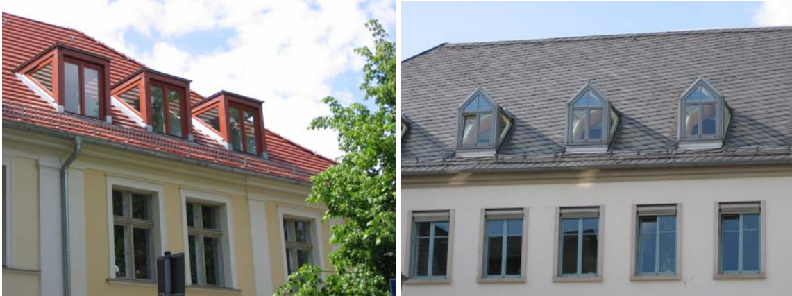
Bsp.18/19: Gebäude mit Dachflächen, die nie Dachaufbauten besaßen, erfordern besondere Sensibilität bei der Ausweitung der Nutzflächen. Die modern gestalteten, transparenten Gauben fügen sich auch durch die angepasste Farbgebung gut ein, versuchen aber nicht, durch historisierende Gestaltung vorzugeben, Teil der historischen Substanz zu sein. (Potsdam/ Saalfeld)
