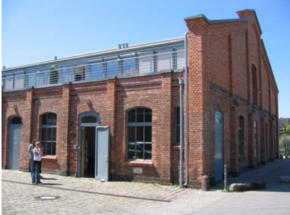
Bsp.5: Und noch einmal gründerzeitlicher Industriebau: der Umbau für eine Büronutzung realisiert mit dem zurückgesetzten Obergeschoss (auf der Südseite) sogar eine Dachterrasse (während die hier nicht sichtbare Nordfassade weitgehend geschlossen ist). Die Auseinandersetzung mit dem Bestand schafft für die heutige Nutzung ganz neue Qualitäten, die ein Neubau nur schwer erzielen kann. (Berlin-Prenzlauer Berg)
