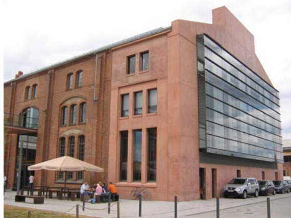
Bsp.4: Eine ausgedehnte Fabrikanlage erfährt eine neue Nutzung als Hochschule. Die Grundsubstanz ist mit ihren epochetypischen Details instandgesetzt, sodass die typische Industriearchitektur der Entstehungszeit für Jedermann sichtbar ist. Der Eingangsbereich wird mit einem deutlich sichtbaren Bauteil – in moderner Formensprache und zeitgemäßem Material – betont. Nachträgliche Ergänzungen der Baukörper sind deutlich erkennbar. Auf eine historisierende Formensprache oder gar eine Kopie wird verzichtet, Fensteröffnungen und Fassade übernehmen die Grundstruktur und Gliederung des historischen Bestandes, entwickeln jedoch eine gewisse Eigenständigkeit. (Wildau)
