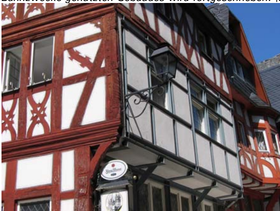
Bsp.13: Teile der Fachwerkfassade mussten erneuert werden. Statt einer Rekonstruktion der verlorenen Substanz wurde deren Struktur modern nachempfunden, mit einem Material, welches heute für derartige statische Aufgaben angemessen ist. Die Metallprofile in dezenter, bewusst anderer Farbgebung machen ehrlich sichtbar, wo die neue Konstruktion die historische Substanz ersetzen musste. (Limburg)
