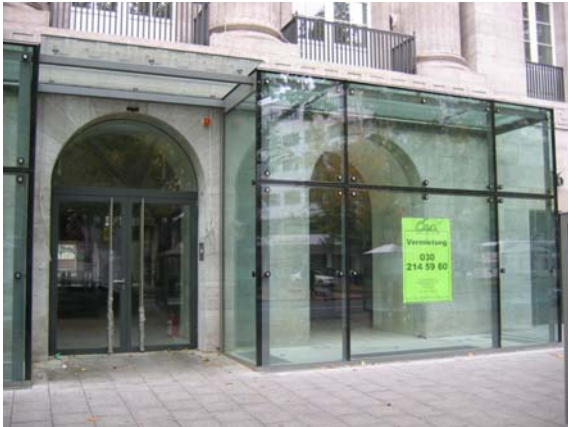
Bsp.10: Heutige Ladennutzungen benötigen andere Präsentationsformen als in früheren Zeiten. Ein Schaufenster als ein vor die Fassade gesetzter Schaukasten, hinter dem die alte Substanz erhalten und sichtbar bleibt. Die in den Innenstädten häufig zu beobachtende vollständige Aushöhlung der Erdgeschossfassade für Schaufenster ist mit dieser kreativen Lösung vermieden worden. (Berlin-Charlottenburg)
