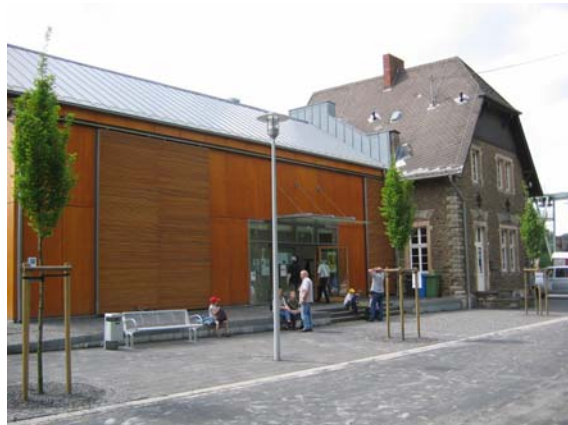
Bsp.11: Von der Herstellung zum Verkauf: die alte Laderampe vor der Lagerhalle ist nun ein gastronomischer Bereich mit besonderem Flair. Die Toröffnungen sind durch die Verglasung ablesbar, die Schiebetore sorgen für die Ablesbarkeit der alten Nutzung, auch für den Laien. (Berlin-Prenzlauer Berg)
