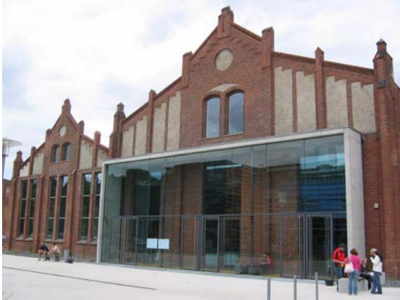
Bsp.4: Eine ausgedehnte Fabrikanlage erfährt eine neue Nutzung als Hochschule. Die Grundsubstanz ist mit ihren epochetypischen Details instandgesetzt, sodass die typische Industriearchitektur der Entstehungszeit für Jedermann sichtbar ist. Der Eingangsbereich wird mit einem deutlich sichtbaren Bauteil – in moderner Formensprache und zeitgemäßem Material – betont. Nachträgliche Ergänzungen der Baukörper sind deutlich erkennbar. Auf eine historisierende Formensprache oder gar eine Kopie wird verzichtet, Fensteröffnungen und Fassade übernehmen die Grundstruktur und Gliederung des historischen Bestandes, entwickeln jedoch eine gewisse Eigenständigkeit. (Wildau)
