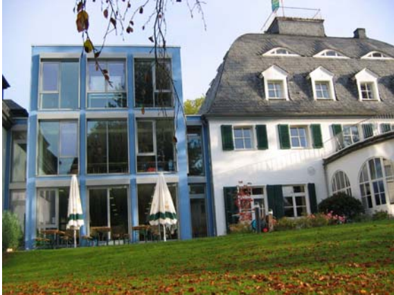
Bsp.7: Hauptgebäude und Anbau entstammen erkennbar unterschiedlichen Epochen. Jedes hat seine eigene individuelle Formensprache. Eine Fortführung des Altbestandes hätte dessen Erscheinungsbild massiv verändert und durch den Eingriff in die Dachform unbefriedigende Ergebnisse mit sich gebracht. Durch die deutliche Fuge unterhalb der Traufe stehen beide Gebäude respektvoll nebeneinander, ohne sich gegenseitig in Frage zu stellen. Dachform, Glasanteil der Fassade und Farbgebung folgen den Gegebenheiten der Entstehungszeit. Welches das „schönere“ Gebäude ist – innen wie außen – darf der Betrachter selbst entscheiden. (Koblenz)
