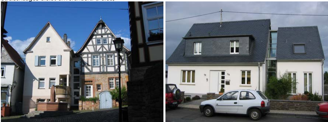
Bsp.15: Fortentwicklung des Bestandes: Auch die Parzellenstruktur kann ein schützenswertes Gut sein. Das Fachwerkhäuser hat nebenan eine Ergänzung in beinahe identischer Kubatur erhalten. Ein gläserner Übergang verbindet beide Häuser. Auf die für heutige Zeit unzeitgemäße Fachwerkkonstruktion) oder gar deren Aufbringen als bloßes Dekor wurde bewusst verzichtet. Die schlichte Gestaltung gesteht dem historischen, sanierten Fachwerkhäuser die Hauptrolle zu. (Ortenberg)
