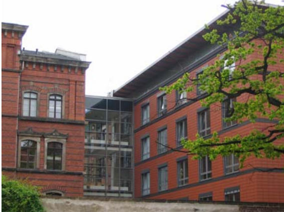
Bsp.8: Ergänzung des Bestandes mit Respekt und Distanz: Die Erweiterung greift Farbgebung, Gliederung (horizontale Bänderung) und Höhe auf. Material und Geschosshöhen entsprechen den heutigen Möglichkeiten und Zwängen. Ein transparenter Übergang macht den „Bruch“ und die Epochen sichtbar. (Goerlitz)
