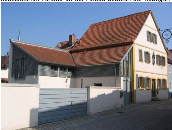
Bsp.17: Diese Erweiterung orientiert sich an den Kubaturen regionaltypischer Nebengebäude. Die besondere Qualität erfährt es durch die Übernahme der Dachneigung des Hauptgebäudes und das Absetzen der Dachfläche. Die Proportionen von (altem) Haupt- und (neuem) Nebengebäude sind klar gegeneinander ablesbar. (Iphofen)
